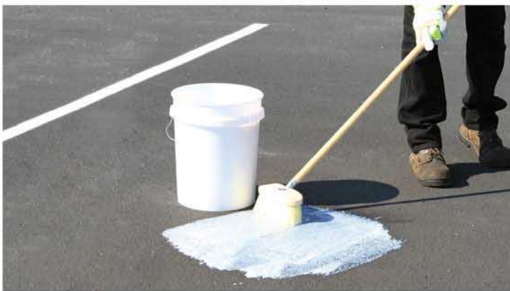
APLICACIÓN DE SEALMASTER PETRO SEAL™
